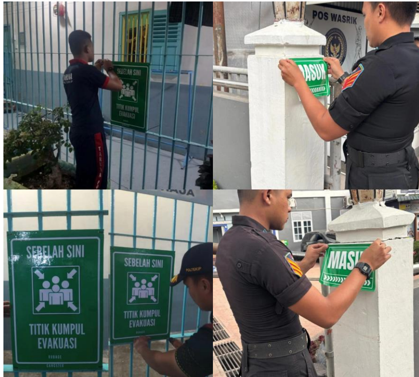
Gambar 3. Pemasangan Titik Kumpul Bencana.
