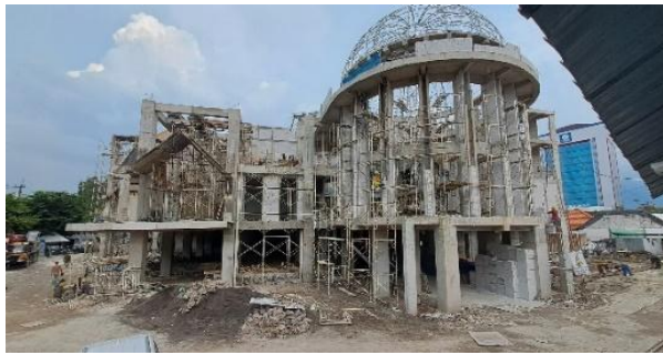
Gambar 2. Proyek Konstruksi Masjid Nuruzzaman (Sumber: Dokumentasi Pribadi)
