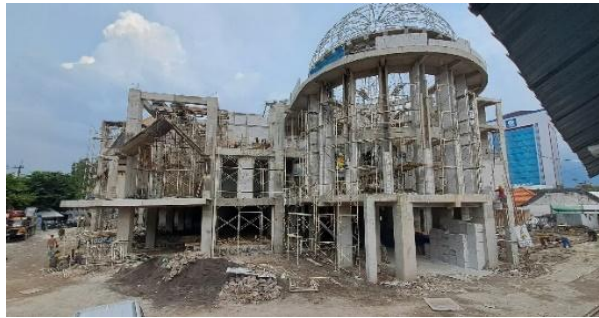
Gambar 2. Proyek Konstruksi Masjid Nuruzzaman (Sumber: Dokumentasi Pribadi)
