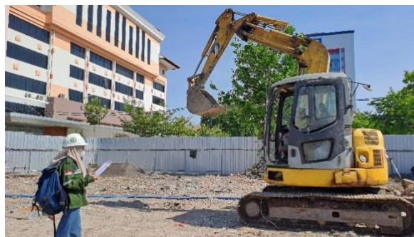
Gambar 3. Excavator Komatsu PC78UU (Sumber: Dokumentasi Pribadi)
