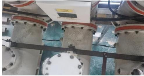
**Gambar 7. Pemasangan plat tembaga di sisi CT dan CVT**
