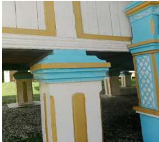
Gambar 1 Struktur Penyangga Rumah Tuan Kadi (Dokumentasi Pribadi)
